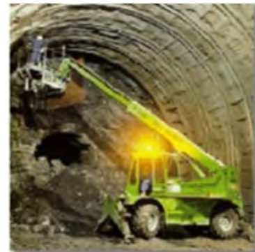
Arbeitsplattform, die mit einem Teleskopstapler zusammengebaut ist
